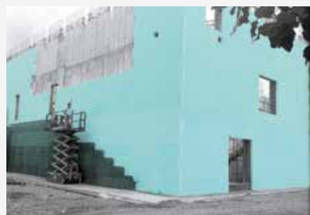
FIBRANxps MAESTRO ako sendvičová izolácia; fázy vonkajšej časti fasády z pohľadového bieleho betónu.
