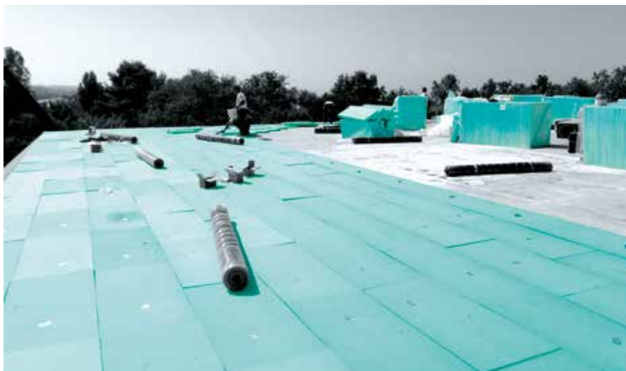
Zväčšenie strešného sklonu budovy s FIBRANxps INCLINE a zároveň tepelná sanácia plochej strechy.
