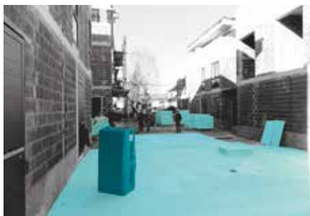
Tepelná ochrana pochôdznej platformy podpivničených bytových jednotiek.
