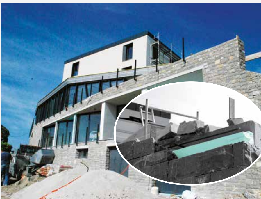
Kamenná fasáda budovy hotela, tepelne izolovaná FIBRANxps ETICS BT , nosnou izoláciou, na ktorej je špeciálnym spôsobom nalepený prírodný kameň.
