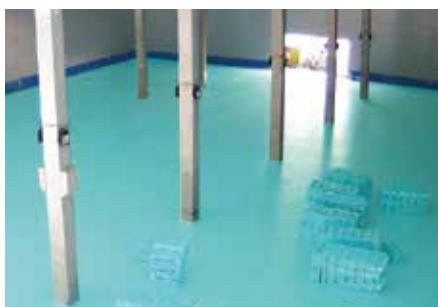
Tepelná izolácia podlahy chladiarne s FIBRANxps 500-L, 700-L.
