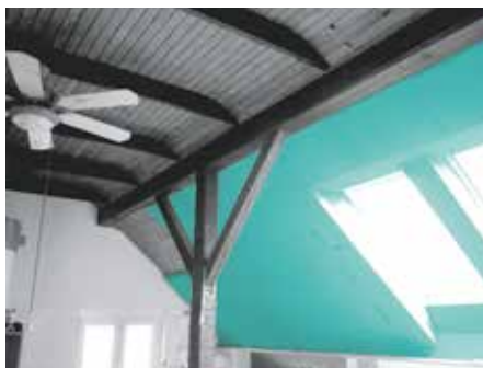
Realizácia vnútornej tepelnej izolácie s FIBRANxps ETICS , ktorú na povrchu chránime vrstvami tenkovrstvovej fasády a omietkou.
