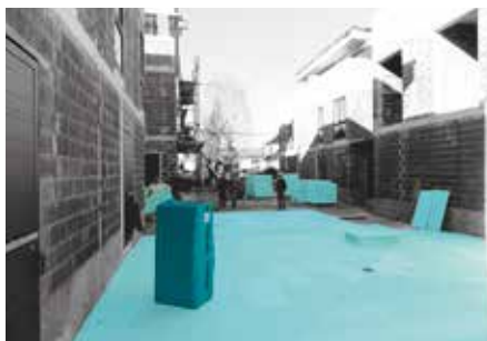
Tepelná ochrana pochôdznej platformy podpivničených bytových jednotiek.
