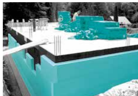
Pevná, prakticky nenasiakavá izolácia FIBRANxps 300-L je mechanická ochrana hydroizolácie a trvácna tepelná ochrana podzemnej časti budovy aj v prípade vysokej hladiny podzemnej vody.
